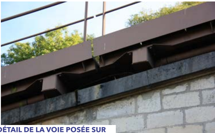
DÉTAIL DE LA VOIE POSÉE SUR LE VIADUC EN PIERRE
