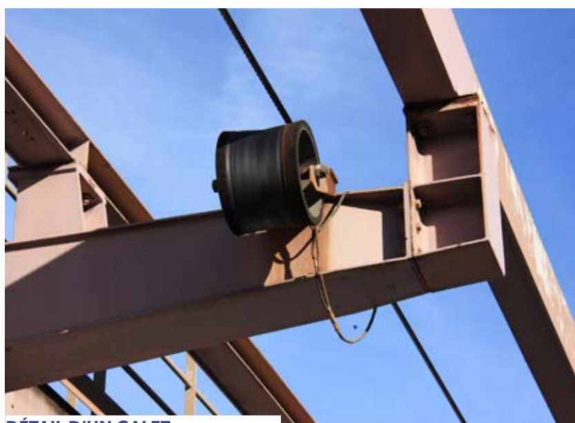
DÉTAIL D'UN GALET, SUPPORT DU CÂBLE TRACTEUR
