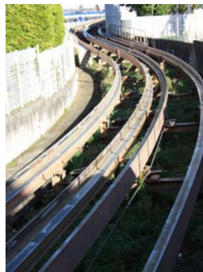
RAMPE POUR LE PASSAGE VIADUC
