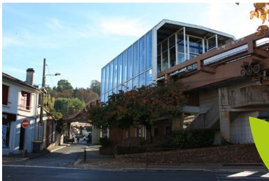
VIADUC AU-DESSUS DE L'ANCIEN TRACÉ DU TRAMWAY
