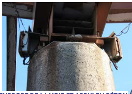
SUPPORT DE LA VOIE ET APPUI EN BÉTON
