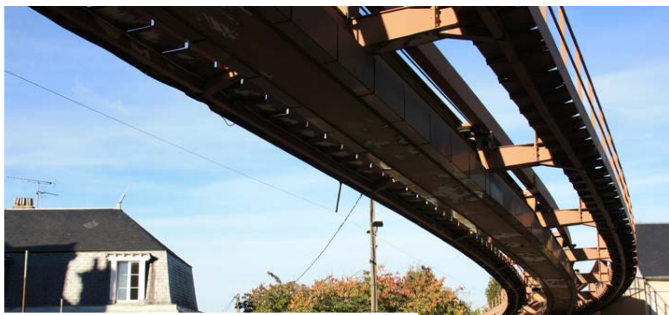
VIADUC AU-DESSUS DU CROISEMENT R. SALENGRO / MONT DE VAUX
